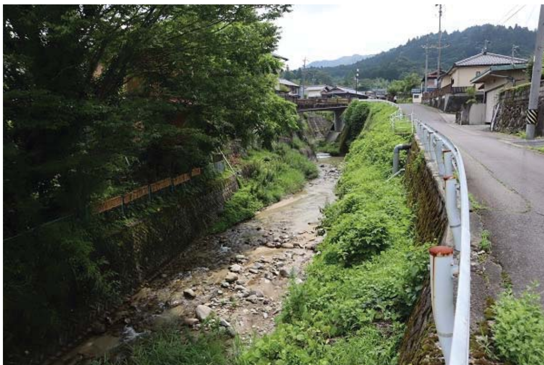
①岩村町日の出地内(一本橋から荒木橋の間) 浚渫
