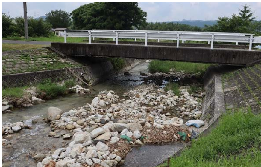
⑤岩村町富田7区地内（石田橋から富田橋の間） 浚渫
