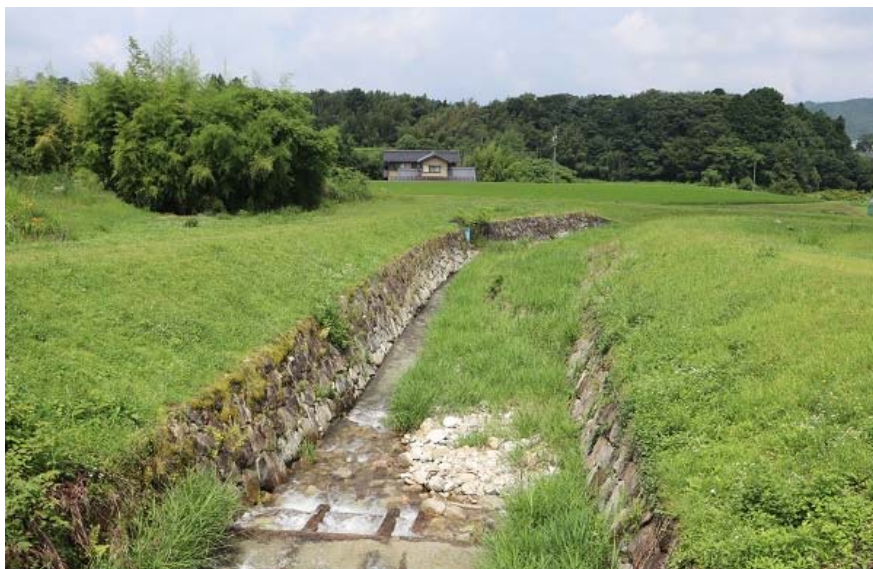
⑥岩村町富田8区地内（寺前橋から吉田川合流地点の間） 浚渫
