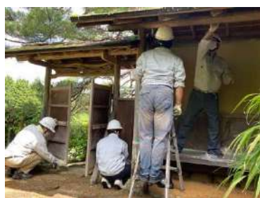
▲塗装作業の様子
