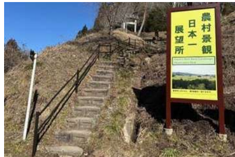
▲展望所の階段に手すりを設置
