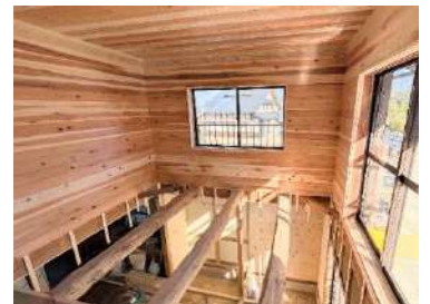
▲リノベーション中の大将陣教員住宅
